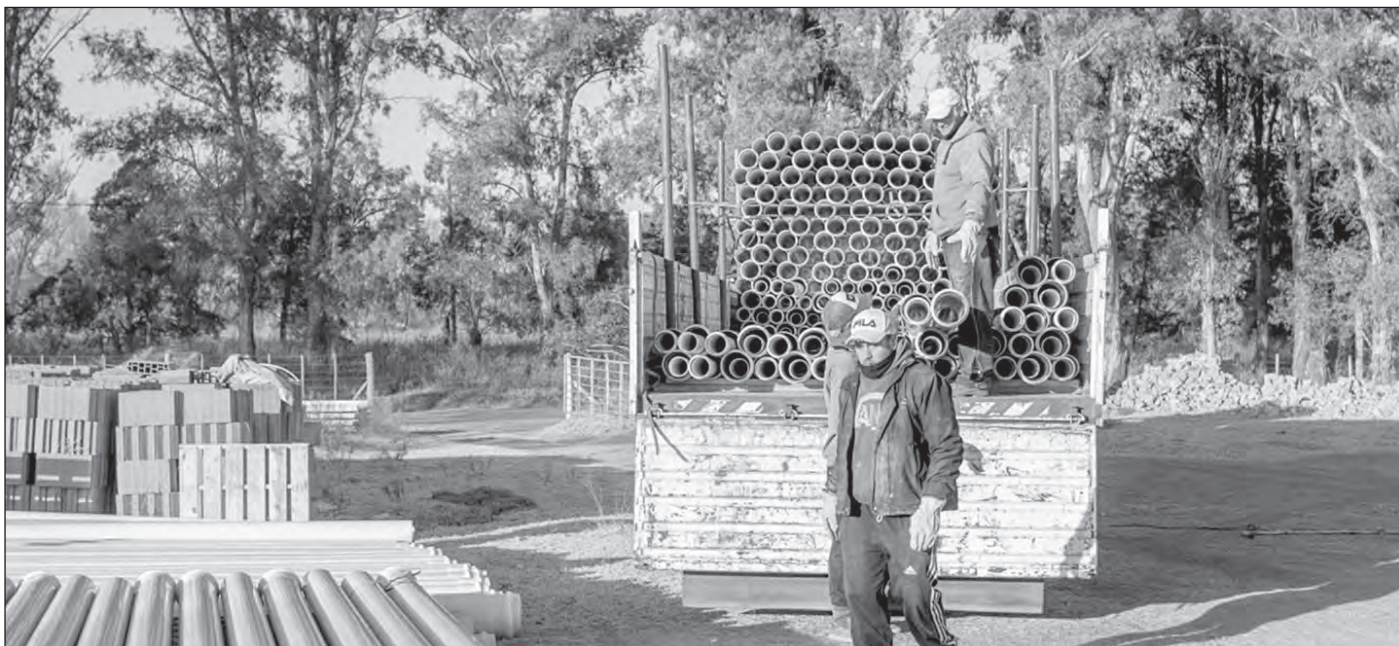
Primera entrega de materiales para la Obra de Redes Colectoras Cloacas
